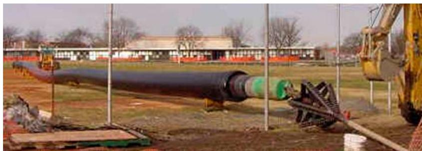
Por último, la tubería se alinea y se fija justo detrás del ensanchador y se introduce, de una sola vez, en el interior de la perforación tirando de ella. Para facilitar la operación los lodos lubrican las paredes de la perforación para reducir el rozamiento. Cuando se recoge el varillaje, la instalación ya está terminada.
